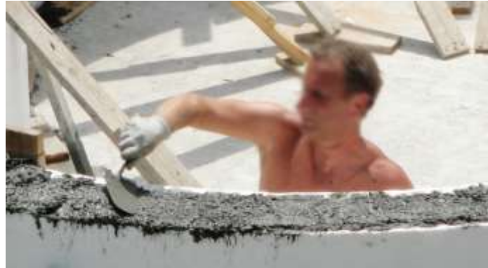
Nivellement de la surface
