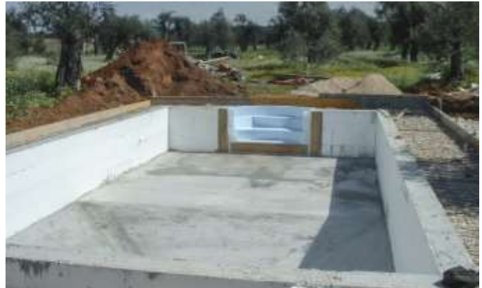
Coulée de béton terminée
