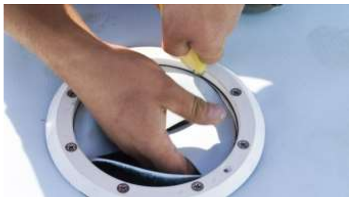
Fixation des pièces à sceller
