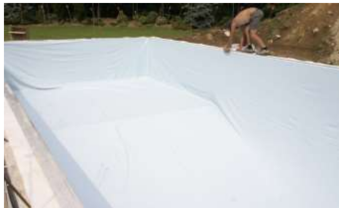
Fixation du liner au guide
