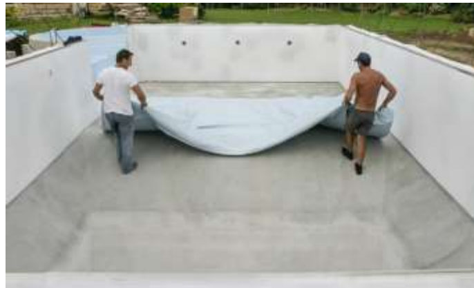
Pose du liner à l'intérieur de la piscine
