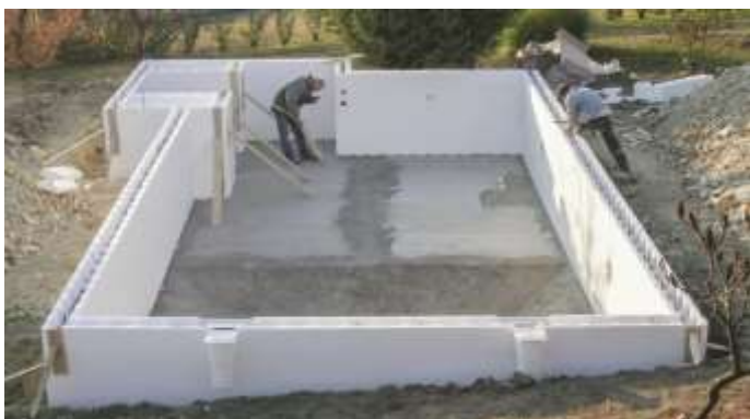
Achèvement des murs avec les coffrages ISOBLOK
