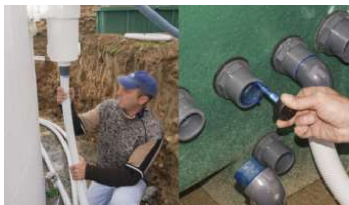
Connexion hydraulique des pièces à sceller
