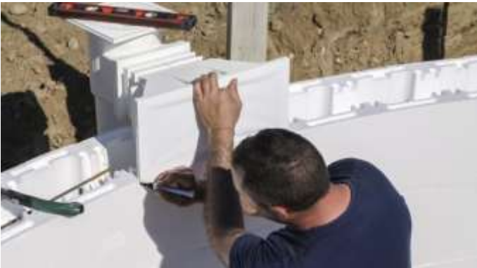
Positionnement des pièces à sceller (traçage de forme)
