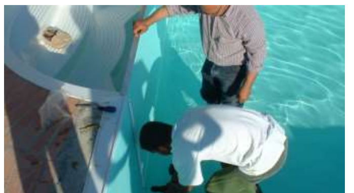
Fixation des pièces spéciales – escalier en fibre de verre
