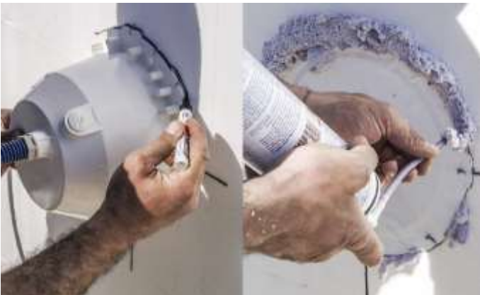
Positionnement des pièces à sceller, traçage et moutage
