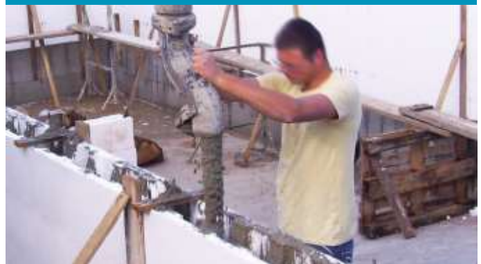
Coulée de béton
