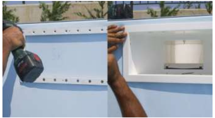
Fixation des pièces à sceller
