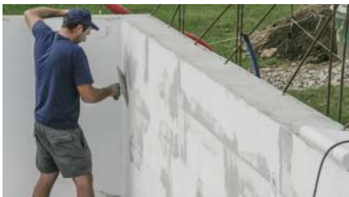
Jointoiment des imperfections sur les parois de la piscine
