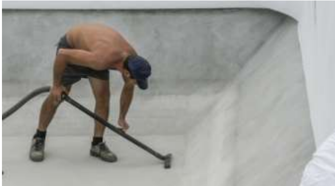
Nettoyage du bassin avant la pose du liner
