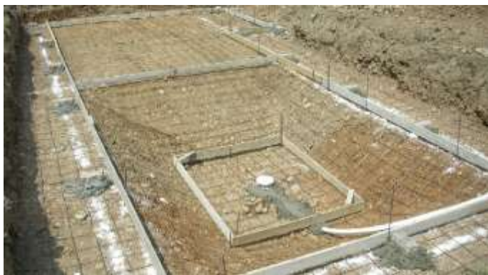
Etablissement des treillis électro-soudés
