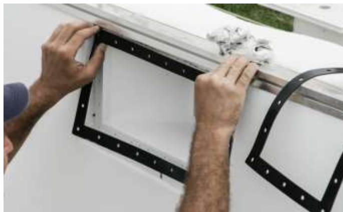
Pose des joints des accessoires
