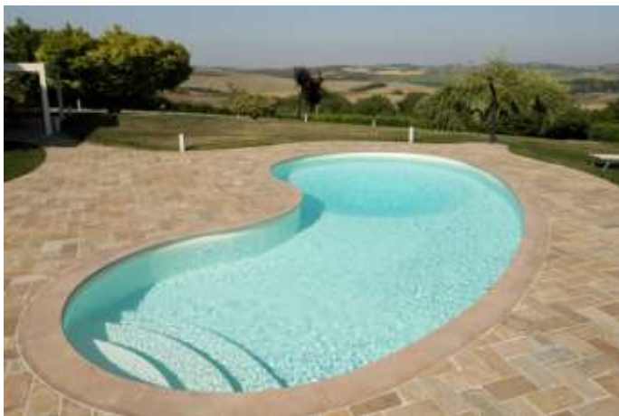
Piscine de forme libre terminée
