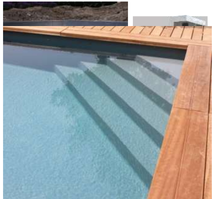
Installation terminée d'un escalier d'angle sous liner
