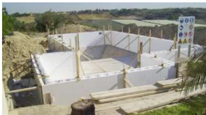
Opération de contreventement des coffrages ISOBLOK
