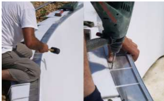
Opération de pose et fixation du guide en aluminium
