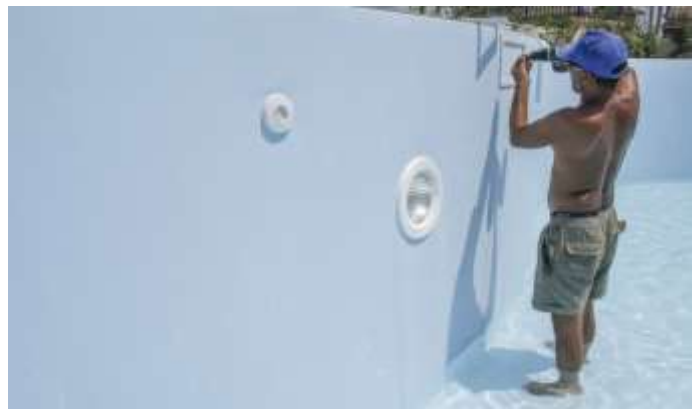
Fixation des pièces à sceller
