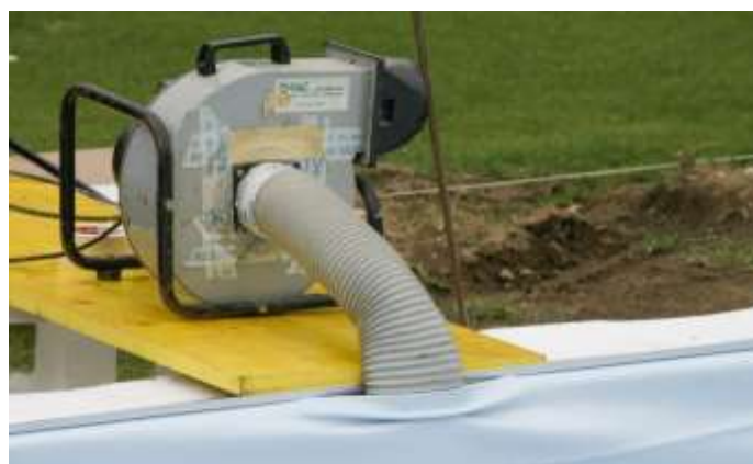
Aspiration de l'air entre le liner et le socle
