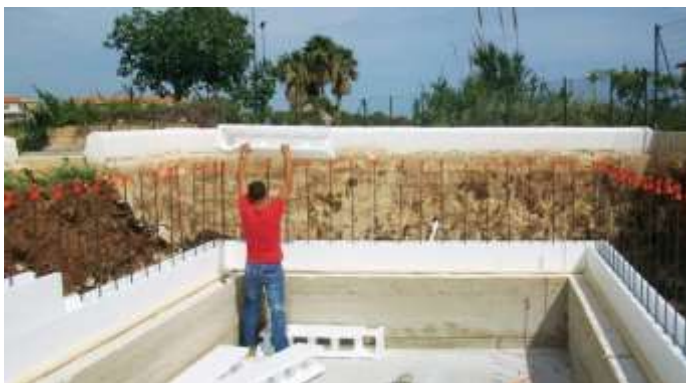
Pose de la ligne des coffrages ISOBLOK
