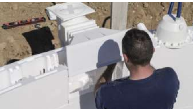
Positionnement des pièces à sceller (insertion de forme)
