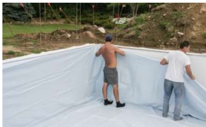
Accrochage du liner au profil supérieur
